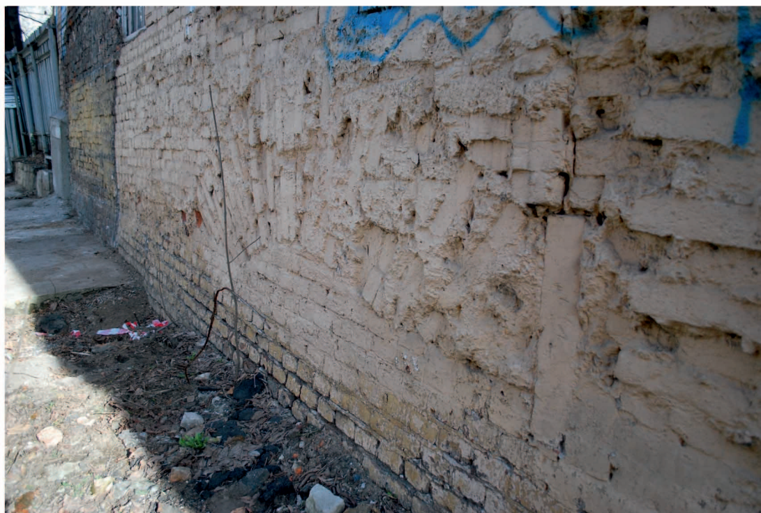
Рис. 4. Разгрузочная арка в юго-западной стене д. 4, стр. 5 по Кривоколенному пер. Устроена на месте засыпанной древней ложины.
