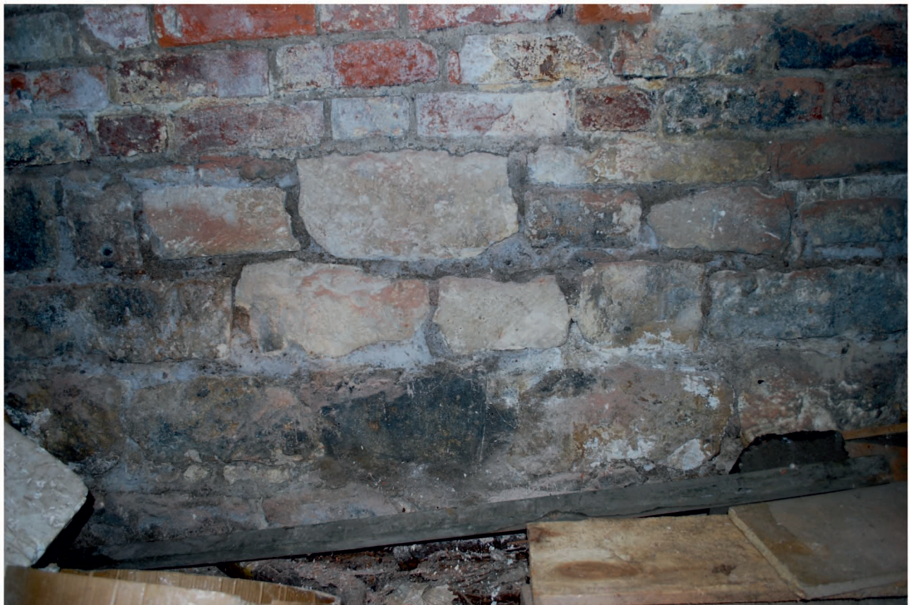
Рис. 7. Угольный подвал под двором дома 5/3 по Б. Златоустинскому переулку. Стены из белого камня и большемерного кирпича на цементе.
