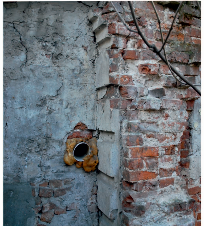
Рис. 14. Кладка из большемерного кирпича на известковом растворе с клеймами сер. - вт. пол. 17 века
