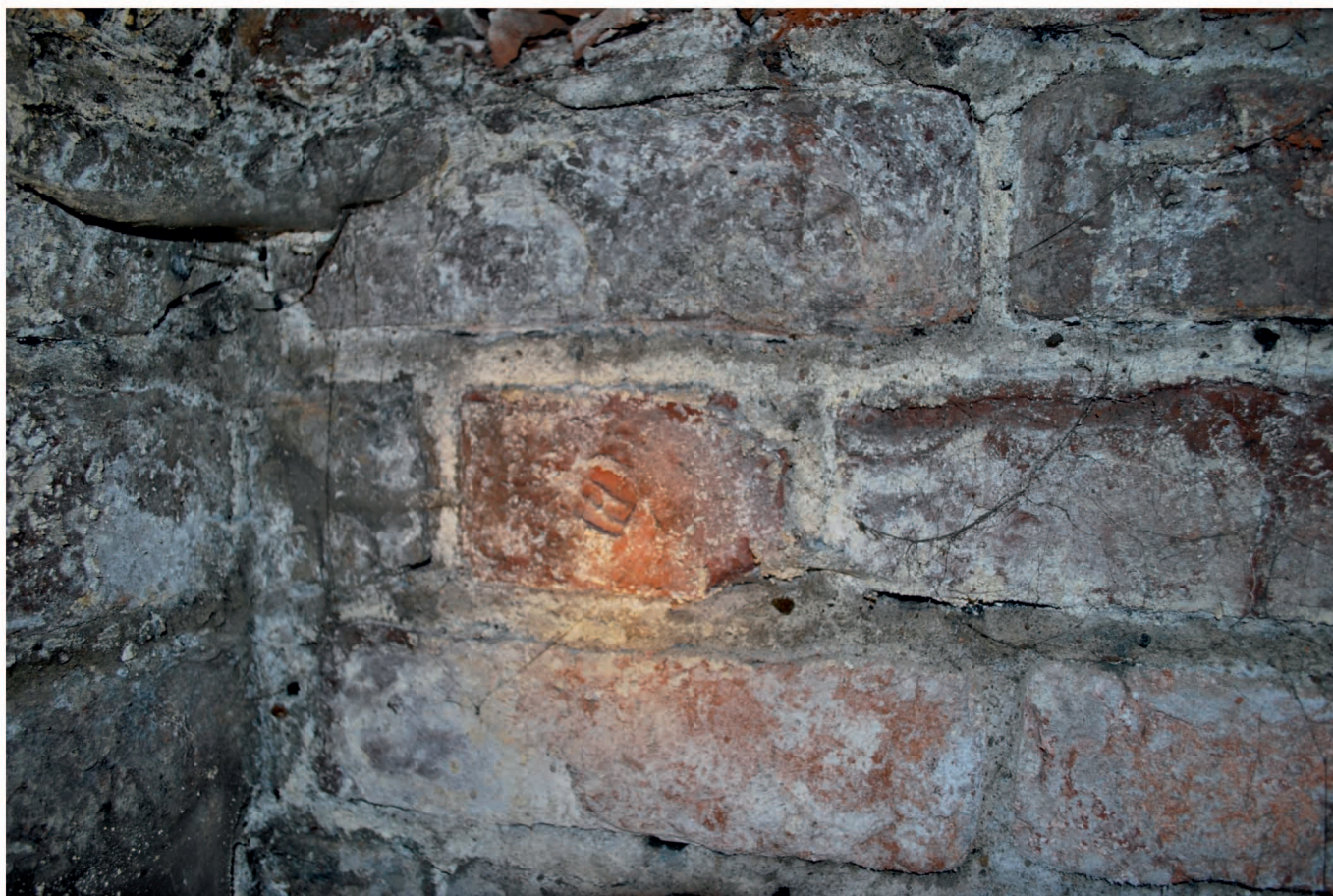
Рис. 8. Угольный подвал под двором дома 5/3 по Б. Златоустинскому переулку. Большемерный кирпич с клеймом конца 17 - начала 18 века..
