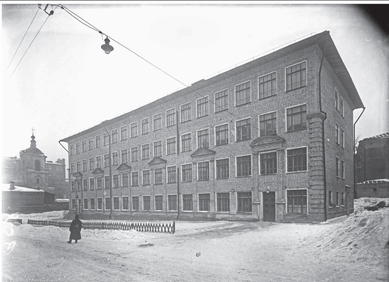
Рис. 12. Школа по проекту архитектора М. О. Барца. Зима 1935 года. Вид с востока.
