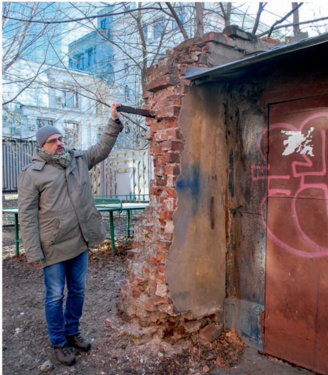
Рис. 15. Железные кованые связи в кирпичной кладке.
