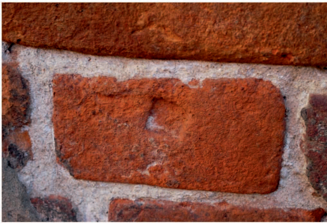
Рис. 14. Кладка из большемерного кирпича на известковом растворе с клеймами сер. - вт. пол. 17 века
