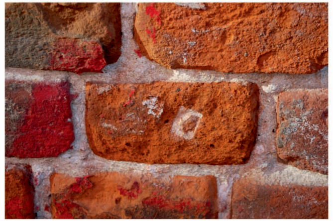
Рис. 14. Кладка из большемерного кирпича на известковом растворе с клеймами сер. - вт. пол. 17 века
