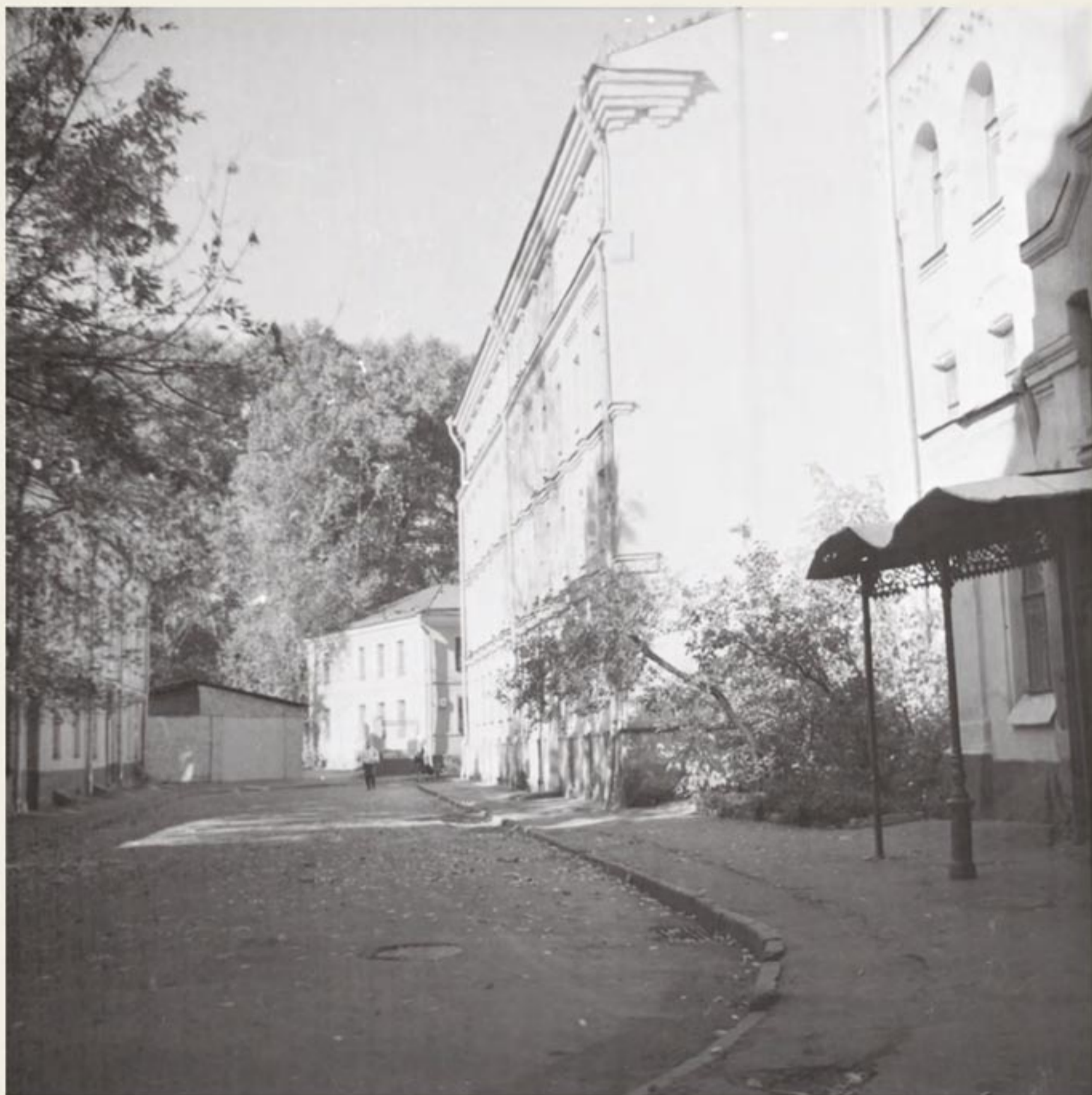
Вид на дом 5 строение 1 по Малому Златоустинскому переулку 1987 г.
